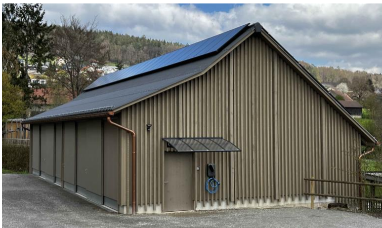
Ökonomiegebäude mit PV-Westdach (Abendpeak: ca. 10 kW)
