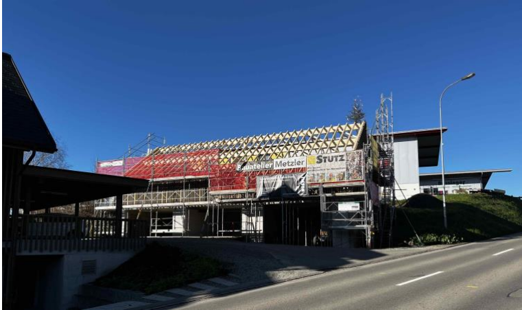
Umbauphase Ökonomiegebäude mit neuem Oberteil für optimale Ausrichtung der PV-Anlage (Ost und West Ausrichtung).
