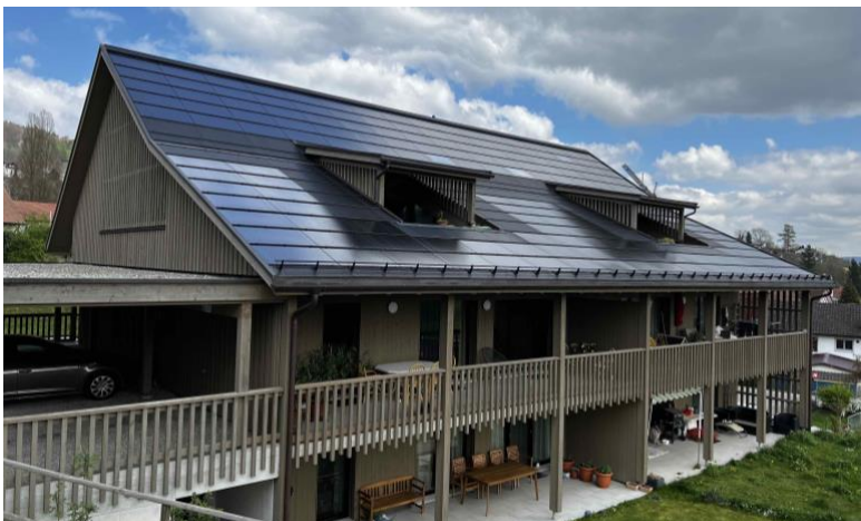
Mehrfamilienhaus mit PV-Süddach (Mittagspeak: ca. 30 kW)
