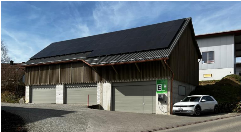
Ökonomiegebäude mit PV-Ostdach (Morgenpeak. ca. 20kW)
